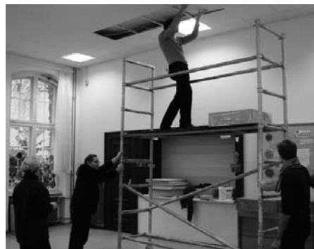
Schall mindernde Deckenplatten im Speiseraum
